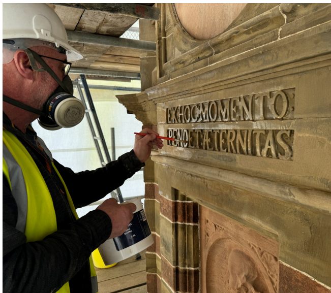
Defnyddio dull Keim ar yr arysgrifiad yn dilyn y gwaith glanhau Keim Colour Washing the inscription following the cleaning work
