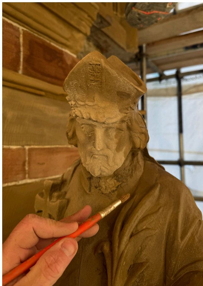
Defnyddio dull Keim ar gerflun Dewi Sant yn dilyn y gwaith glanhau Keim Colour Washing St David following the cleaning work
