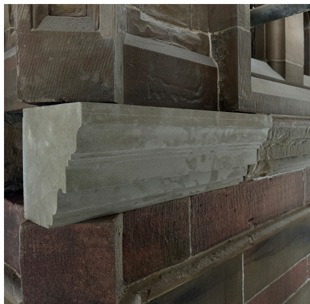
Y llin-gwrs yn dilyn y gwaith adfer String course after restoration
